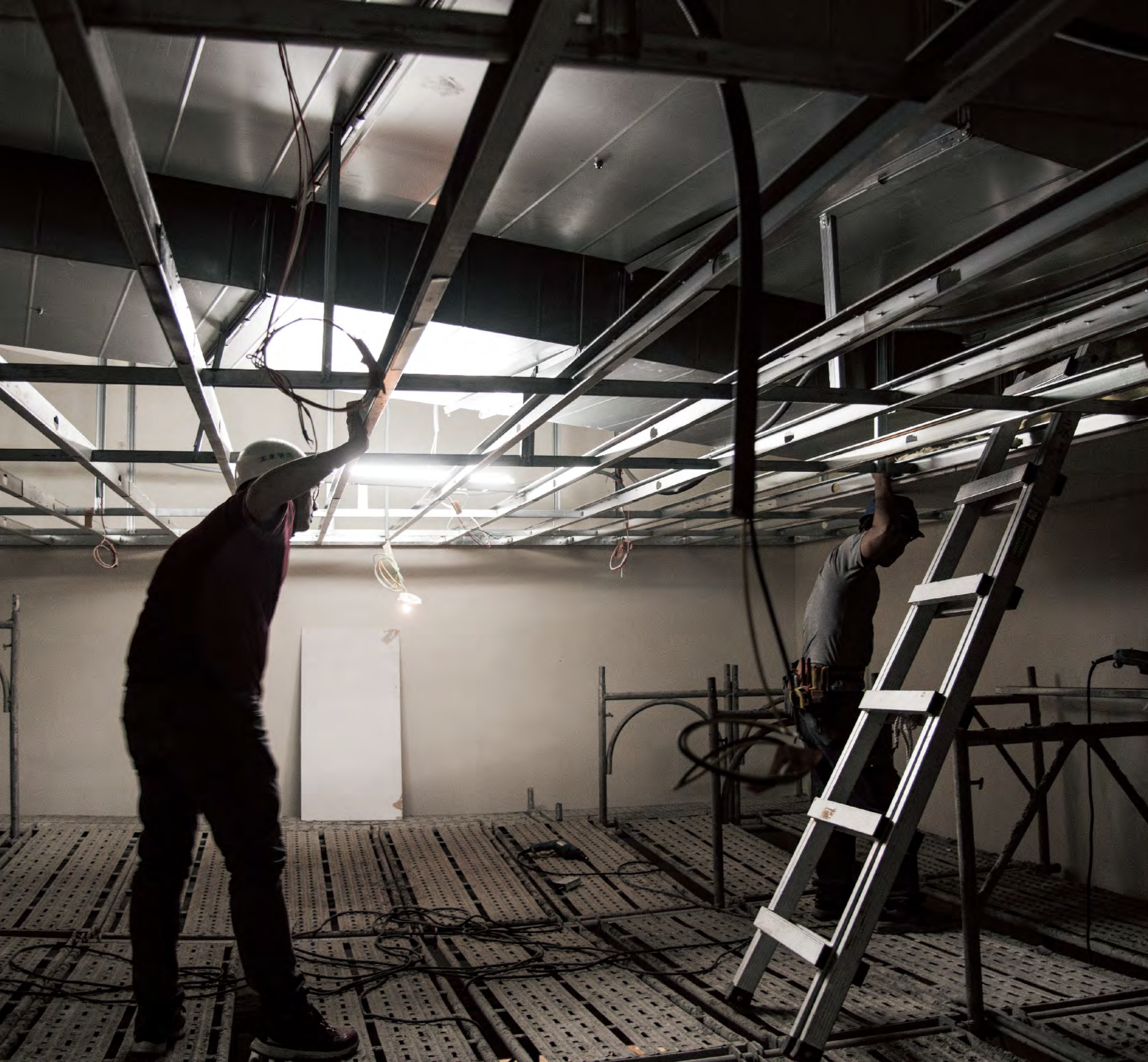
■ 車道抽排風石膏板包板
