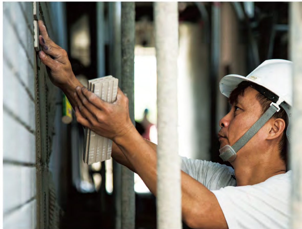
■ 泥牆面磁磚施工
